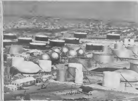
TANKINAN PRETO ta absorba rayonan di solo pasobra tin mester di calor pa yuda pone productonan pini corra door di e tubonan.
